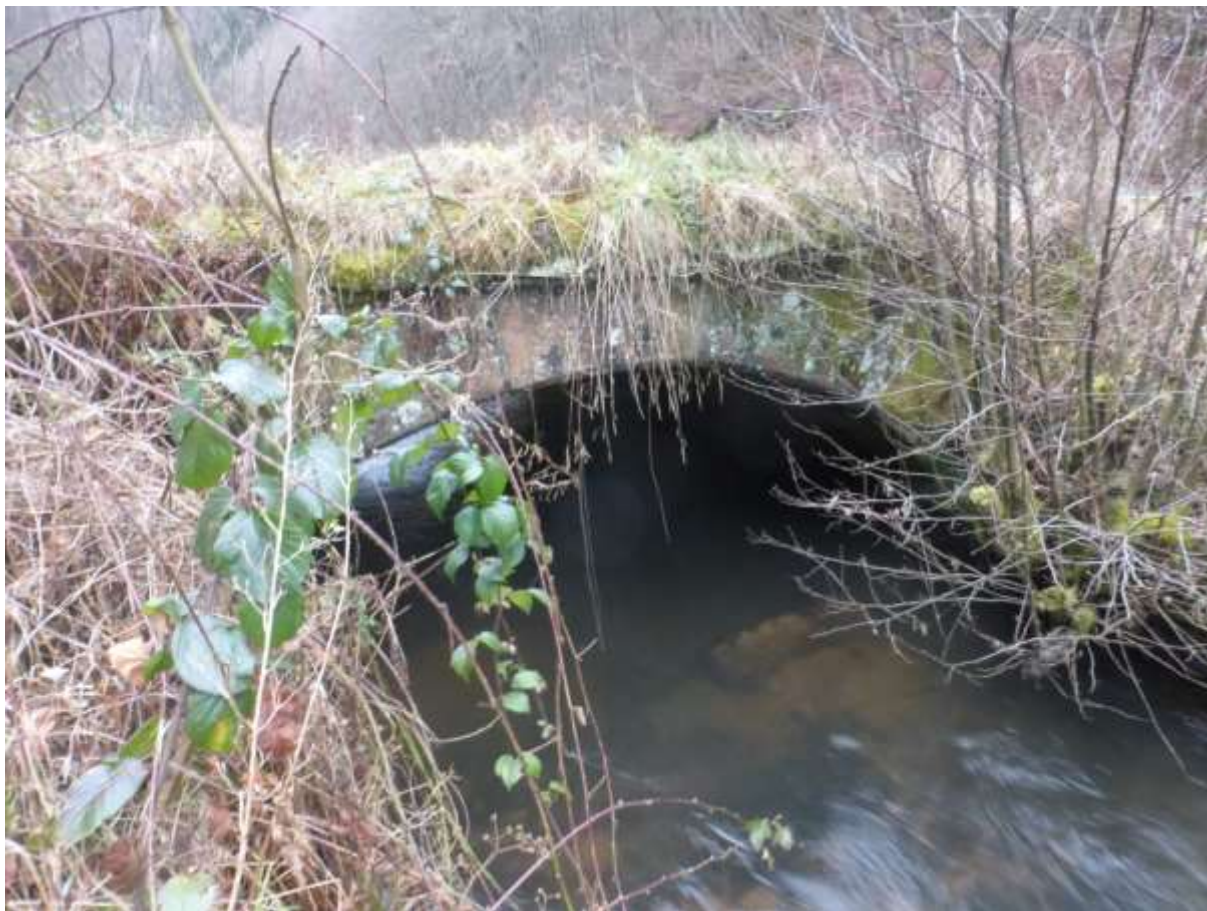
Alte Brücke von 1864 (Einmeisselung)
