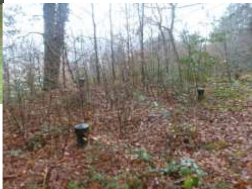
Brunnenhaus im Breitenbachtal (Pumpstation)
