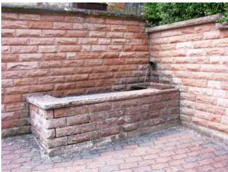
Geiseckbrunnen bevor er vom LKW angefahren wurde
