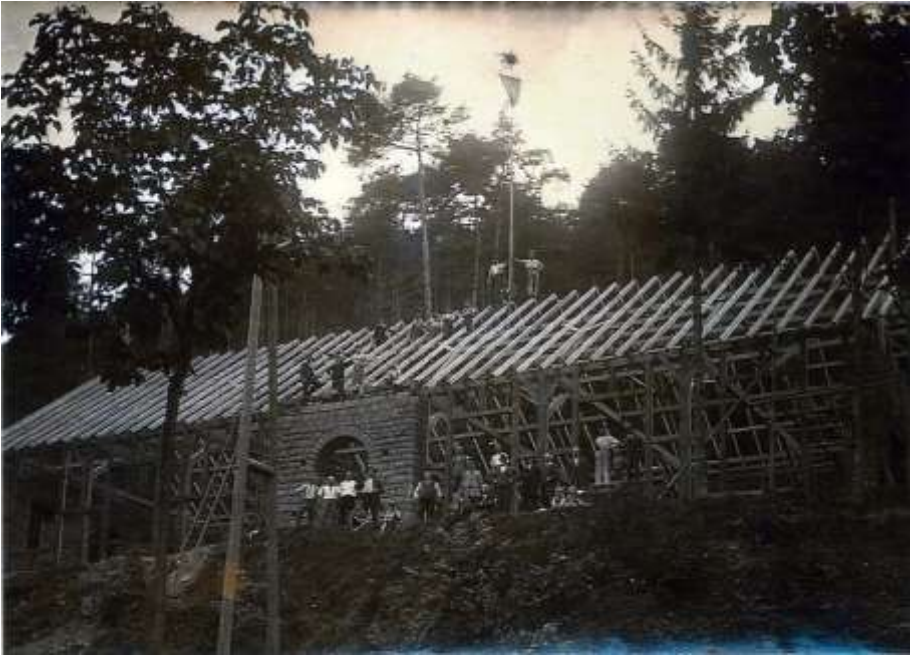
Bau der Turnhalle
