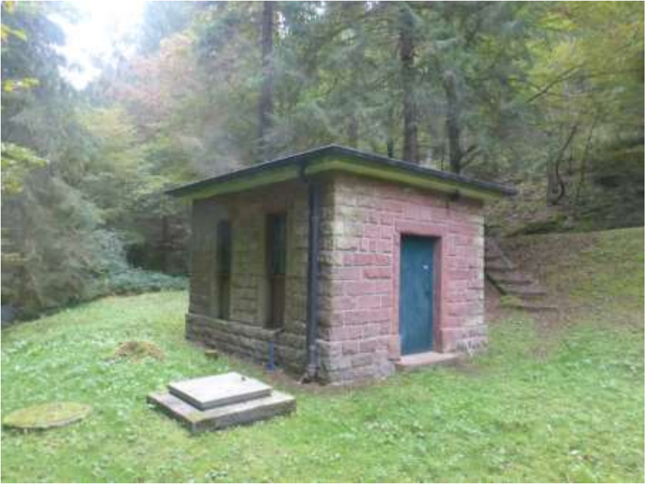
Brunnenhaus im Breitenbachtal (Pumpstation)
