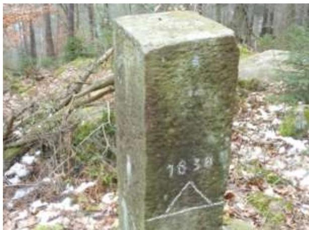
Der Niveaustein stammt von der Ur-Katastervermessung in den Jahren 1837 und 1838 der bayerischen Pfalz. Er ist somit ein Vorläufer der topographischen Punkte, die aus fremdem Granit gefertigt und sehr viel kleiner sind.
